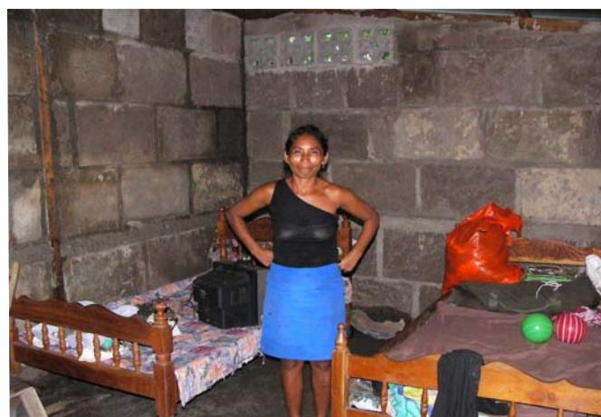
Después que el Proyecto Ometepe-Alemania ayudó a organizar la construcción de casas para algunas de las familias con mas necesidad en Ometepe, comenzó a construir con bloques hechos con botellas plásticas en medio. Usando las botellas reduce basura y reduce la cantidad de concreto necesario para formar el bloque.
